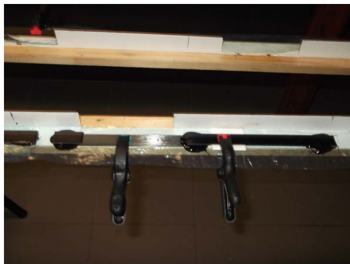
Figura 3.17 - Procedimento de montagem das JSS.
